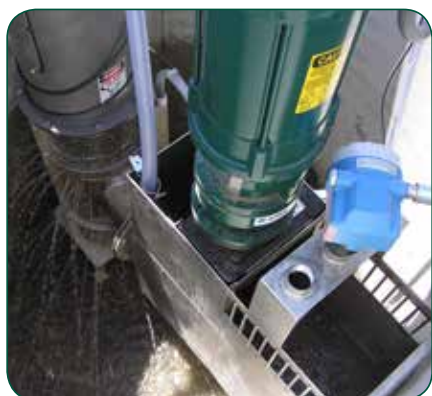
Muffin Monster измельчает твердые предметы
