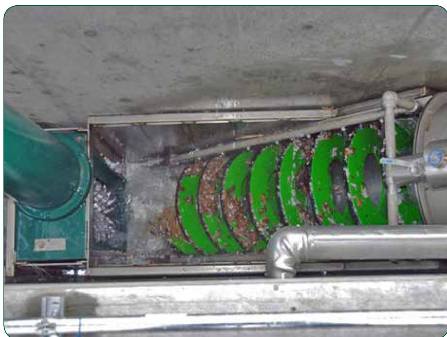
Мусор промывается и поднимается шнеком к выпускному отверстию
