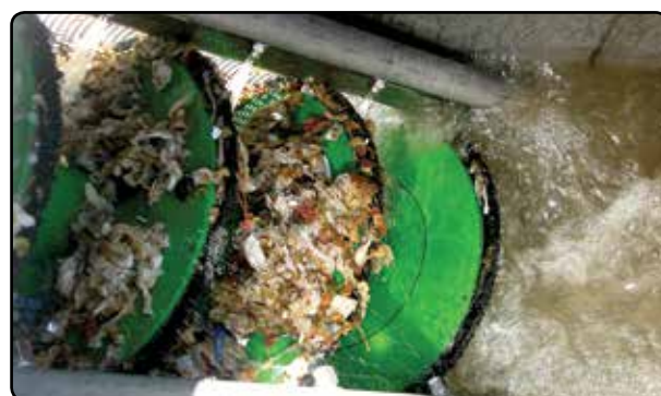
Auger задерживает и удаляет твердые частицы
