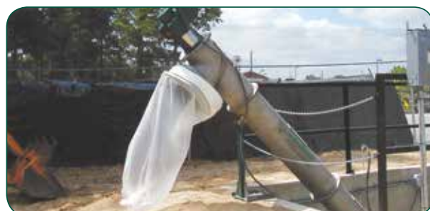
Выгрузка отходов в мешок
